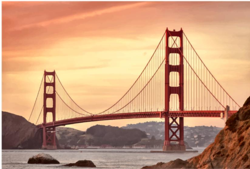
Jembatan Golden Gate adalah sebuah jembatan gantung di sepanjang Golden Gate, dari Samudra Pasifik ke Teluk San Francisco. Jembatan ini menghubungkan Kota San Francisco, California di Semenanjung San Francisco, dan Marin County California. Panjang jembatan keseluruhan 2.727 m, jarak antara menara 1.280 m, dan ketinggiannya 240 m di atas permukaan air.
