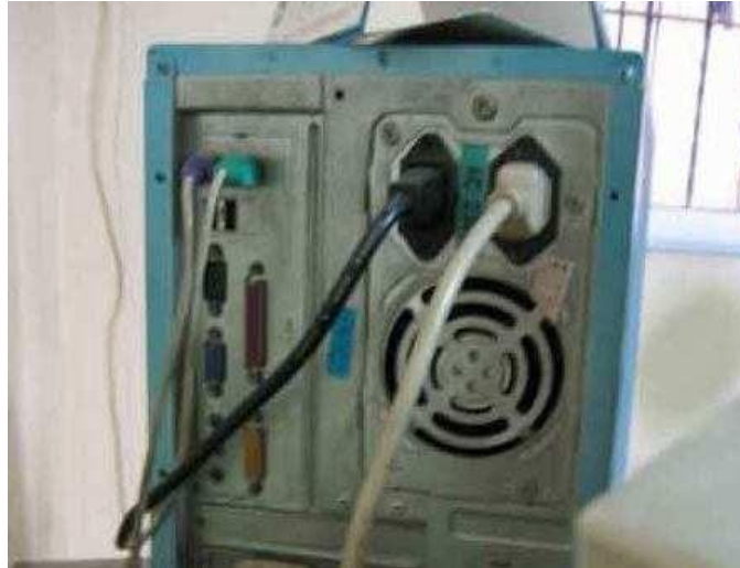
Gambar 30. Pemasangan Kabel Power
